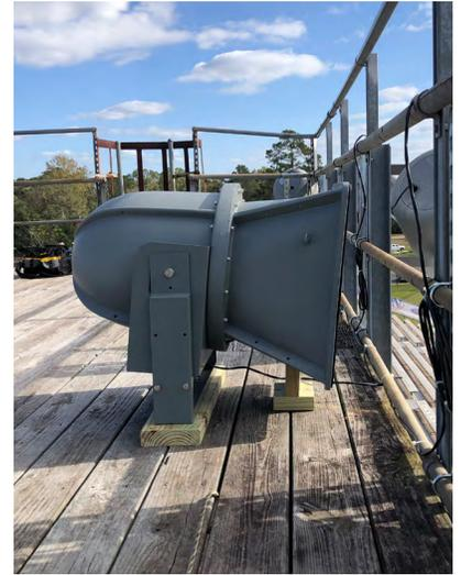
**THE NEW AUDIO SYSTEM FEATURES A SUITE OF AtlasIED OUTDOOR STADIUM HORN SPEAKERS, AMPLIFIERS, POWER SEQUENCER, AND FAN MODULE.**
